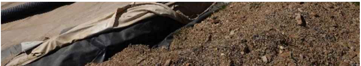
Figura 8.- Zanja Noreste de inspección de láminas de la celda. Detalle de geotextiles
