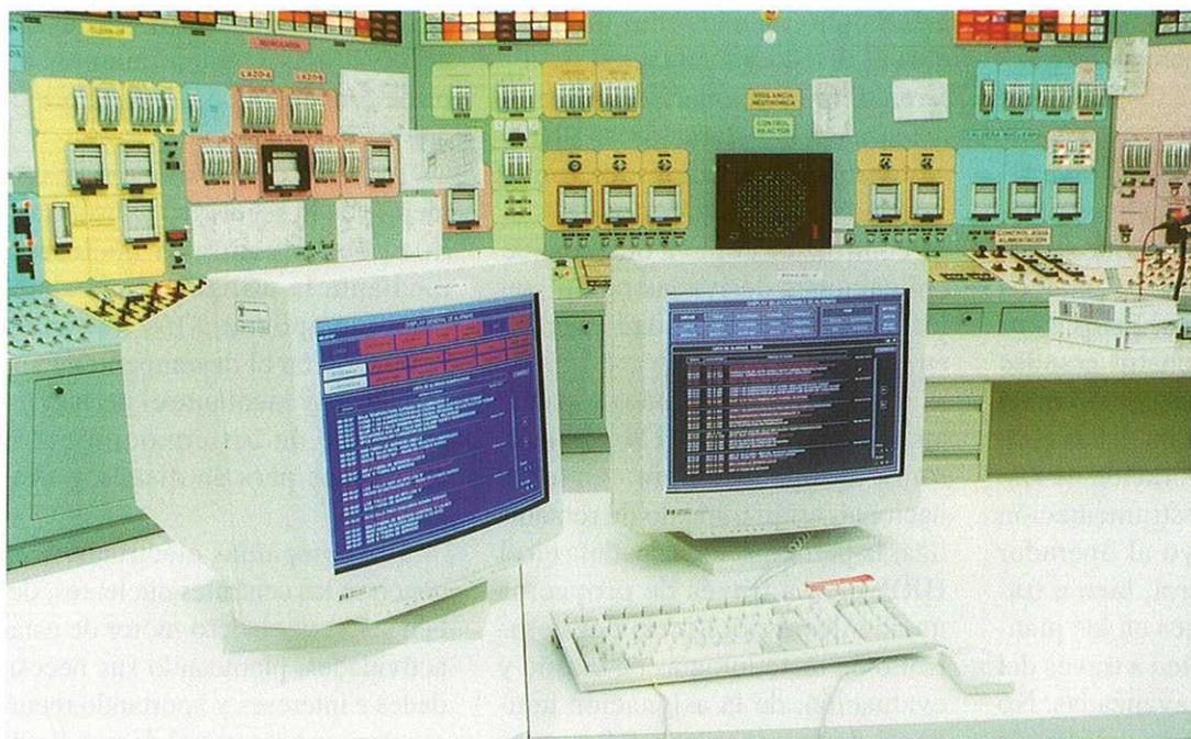
► **Figura 3.** Prototipo del Sistema Avanzado de Tratamiento de Alarmas (SATA) en el simulador BWR de Tecnatom. Este prototipo ha sido desarrollado por el Ciemat y Tecnatom en el marco del Programa de Reactores Avanzados coordinado por la DTN.
