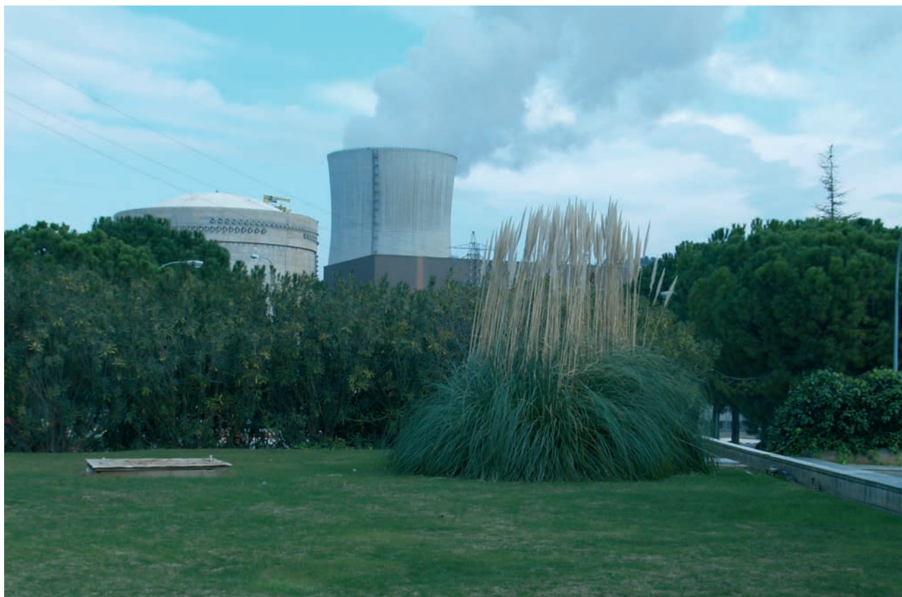
► Panorámica de la central nuclear de Ascó.
