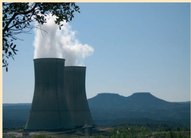
Torres de refrigeración de la central nuclear de Trillo.
