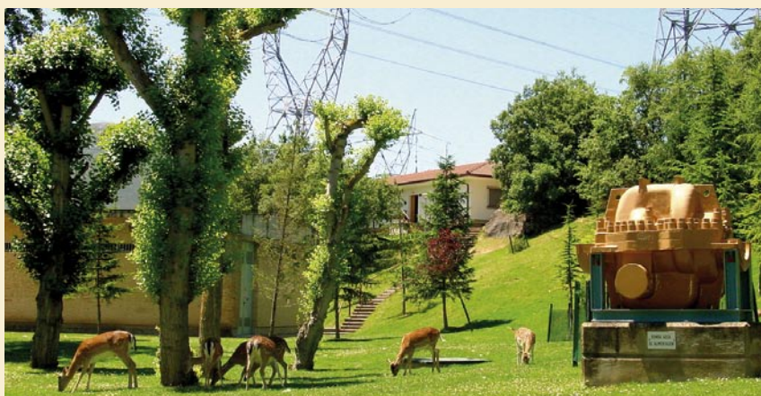
Instalaciones de la central nuclear Santa María de Garoña.
