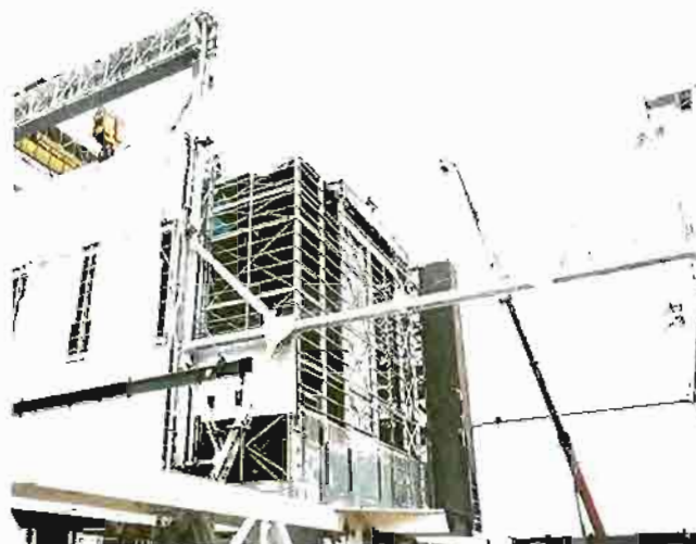
Desmontaje de la central nuclear Vandellós I.
