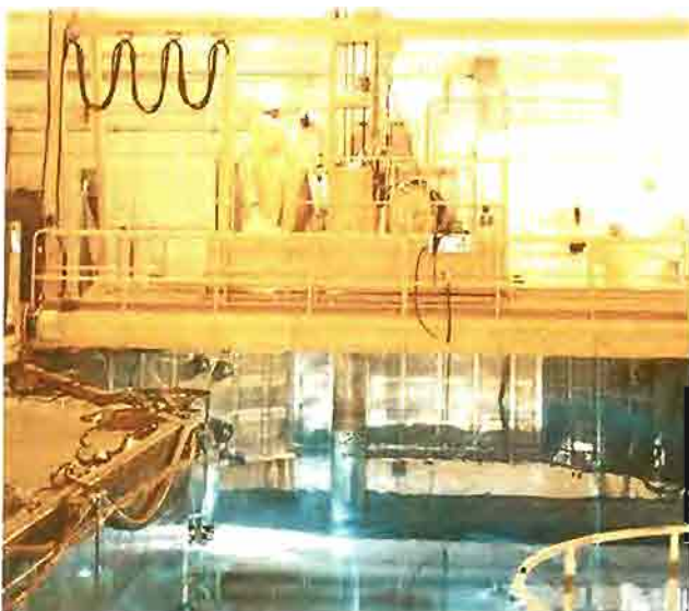
Interior del edificio de contención de la central nuclear de Almaraz.
