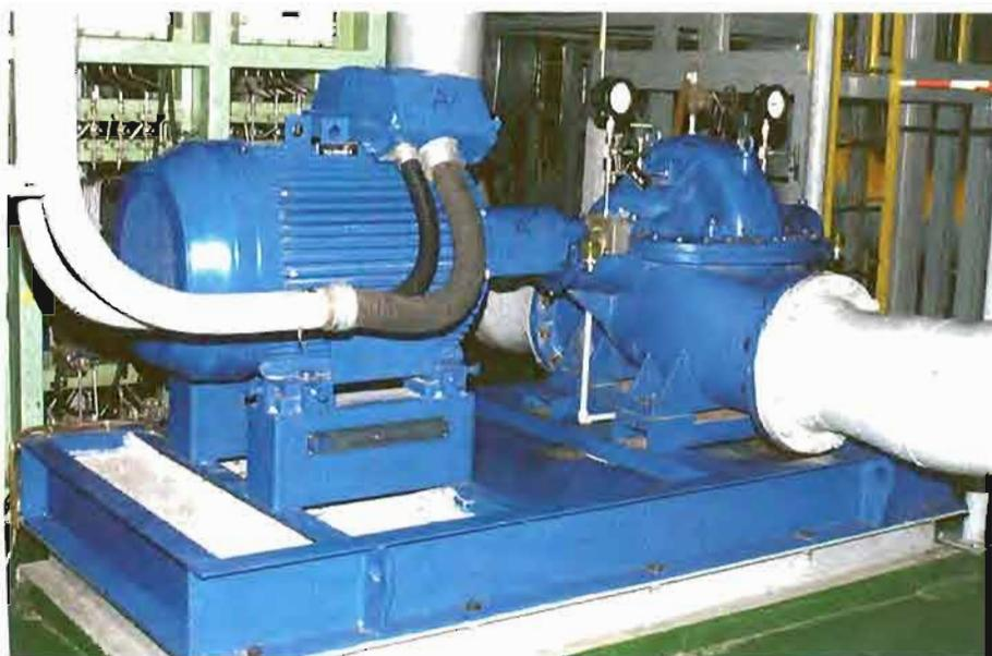
Motobomba del sistema de refuerzo del sistema de refrigeración de componentes del edificio de turbinas de la central nuclear de Almaraz.
