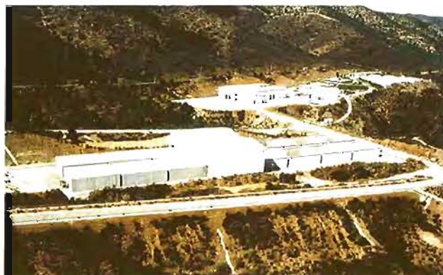
Vista general de las instalaciones de El Cabril.
