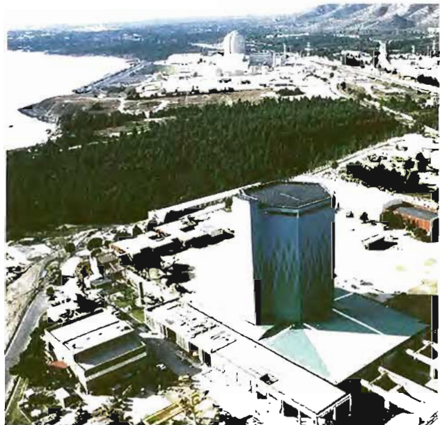
En primer plano, el edificio del reactor de la central nuclear Vandellós I, con su protección de intemperie.
