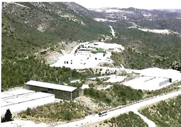
Vista de las instalaciones de almacenamiento de El Cabril.
