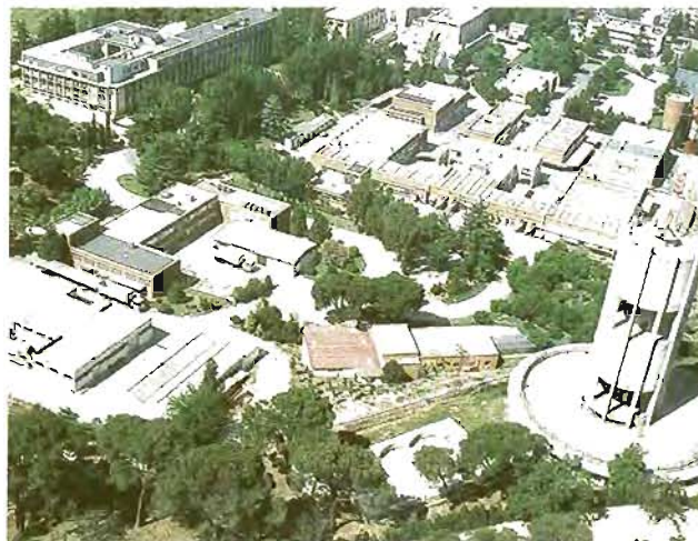
Vista general de las instalaciones del Ciemat.
