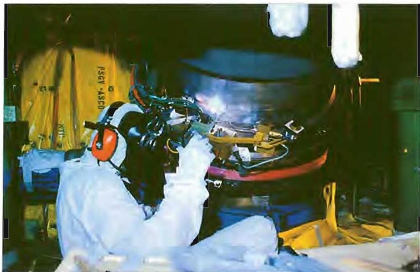
► Figura 1. Trabajos de soldadura en la central nuclear de Ascó durante el cambio de generadores de vapor.
