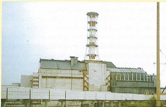
Vista de la central de Chernóbil recubierta por el sarcófago.
