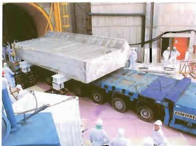
► Figura 2. Extracción de muro biológico en la central nuclear de Ascó I para poder proceder a la sustitución de generadores de vapor.
