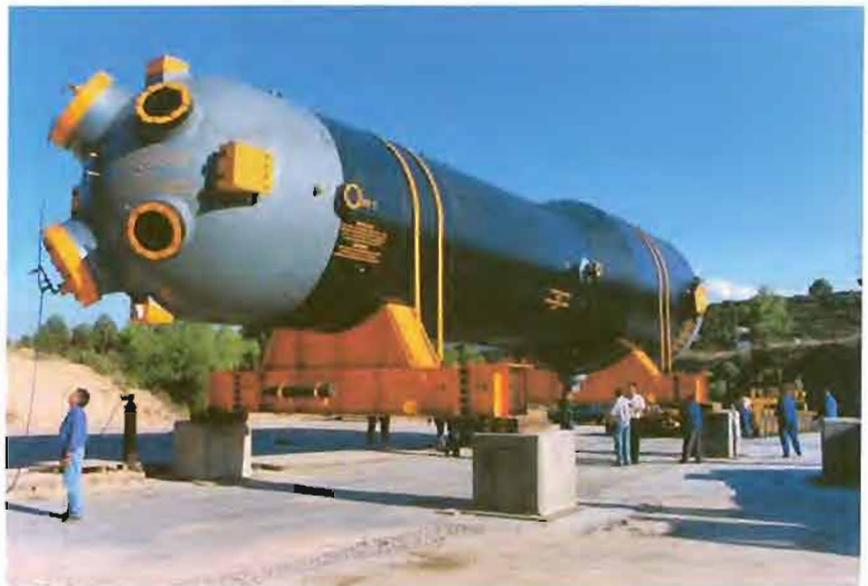
► Figura 5. Almacenamiento del generador de vapor nuevo de Almaraz en la propia central.
