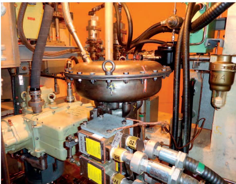
Accionador neumático de la válvula de alivio del presionador. Central PWR de tecnología Westinghouse. (Fuente: CN Almaraz).
