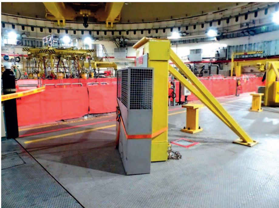
Instalación en una central nuclear de recombinaidores autocatalíticos pasivos (PAR).
