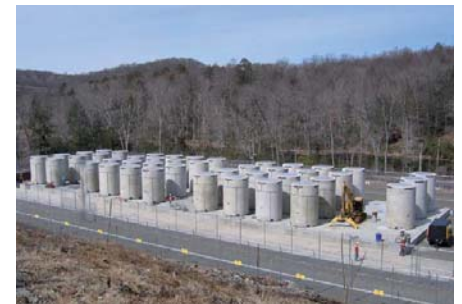
Figura 3. Instalaciones de almacenamiento temporal en Estados Unidos. En la parte superior derecha, vista de la instalación de la central de Surry, con contenedores de doble propósito, en operación desde 1986. En la parte inferior, vista de la instalación de la central Connecticut Yankee (ya desmantelada) con un sistema de cápsula metálica (NAC-MPC).
