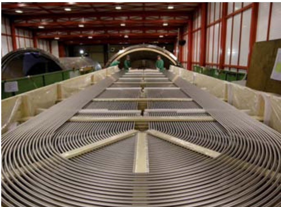
Montaje de haz tubular.
