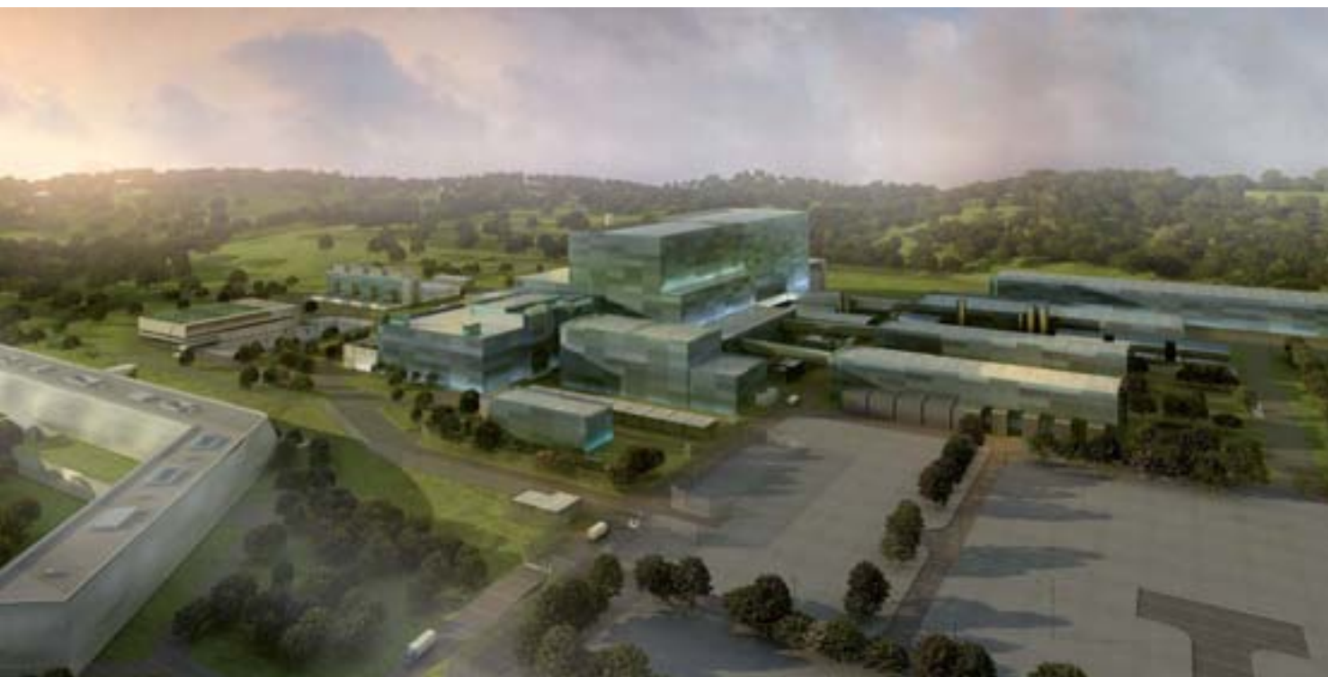
Recreación que muestra cómo quedará el ITER cuando termine de construirse.
