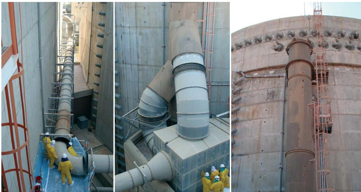
Distintas partes del conducto de ventilación. A la izquierda, operarios realizando su limpieza; en el centro, el plenum de la ventilación; a la derecha, la chimenea de descarga.
