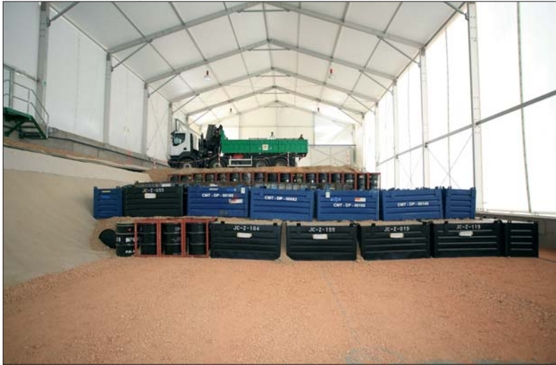
Instalación para residuos de muy baja actividad de El Cabril.
