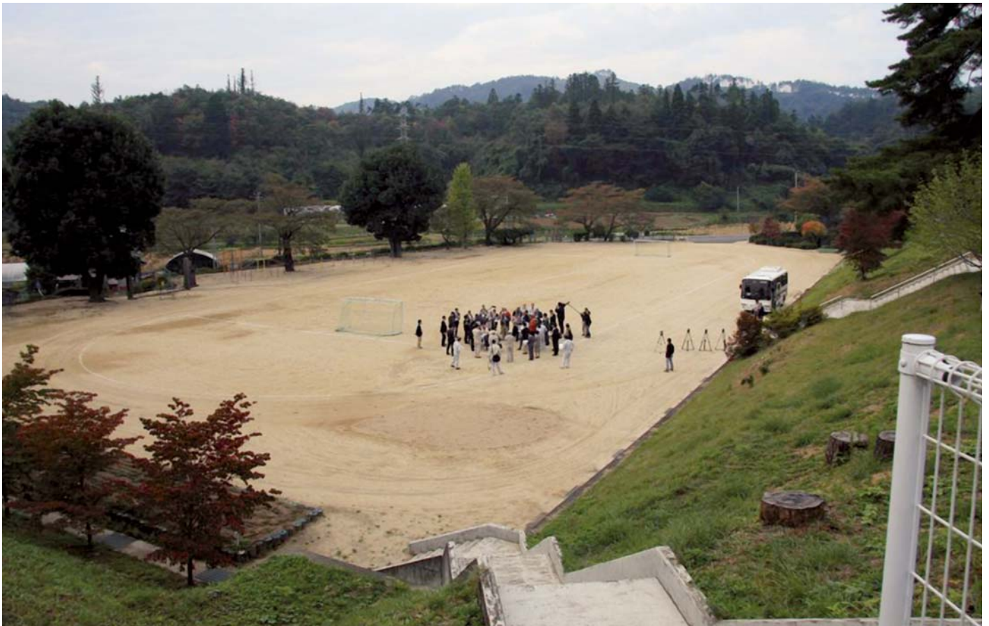
Visita al proyecto de rehabilitación de la Escuela Primaria Tomari (patio), Date [G.Verlinni-OIEA].
