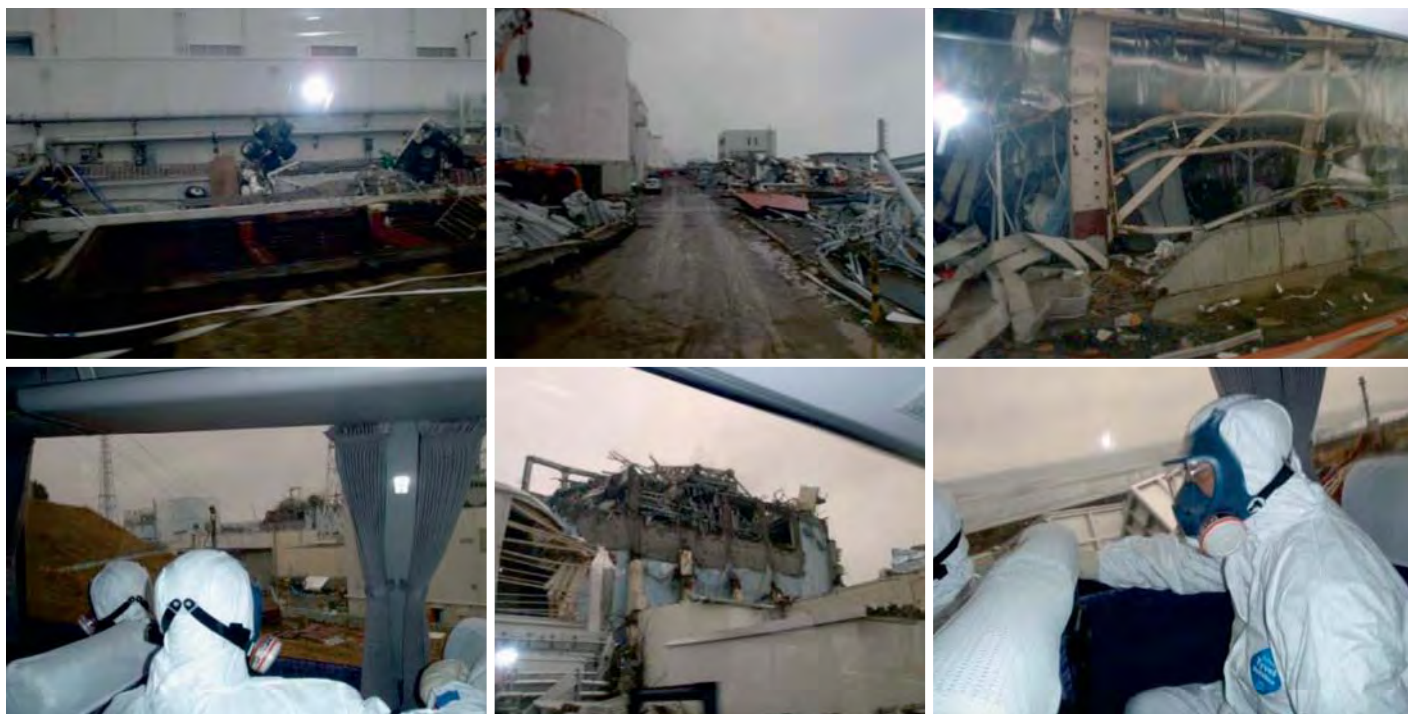
Detalles del estado del emplazamiento y primeros reconocimientos.
