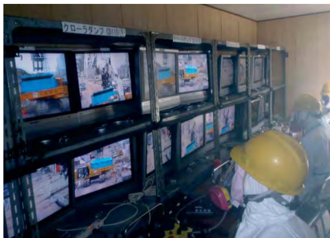
Centro de control remoto de maquinaria.
