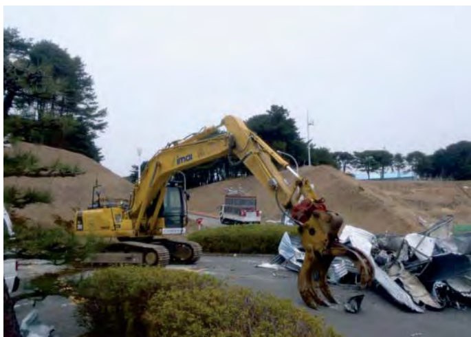
Grúa teledirigida recogiendo escombros.
