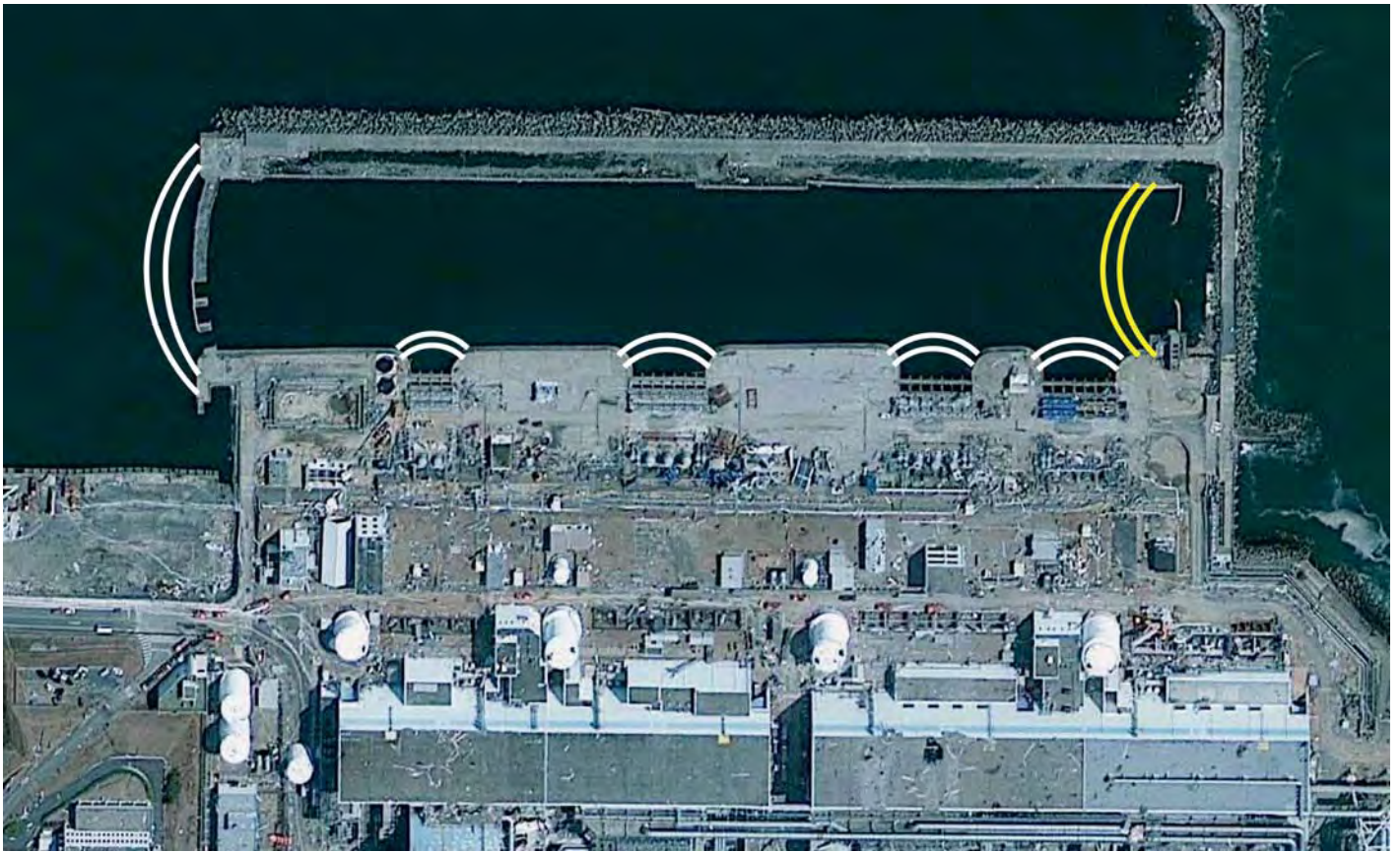
Vista aérea de las barreras de protección para evitar la contaminación al medio ambiente marino.
