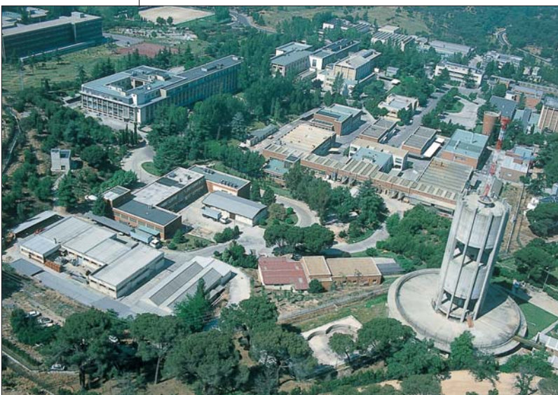
Vista general de las instalaciones del Ciemat en Madrid.
