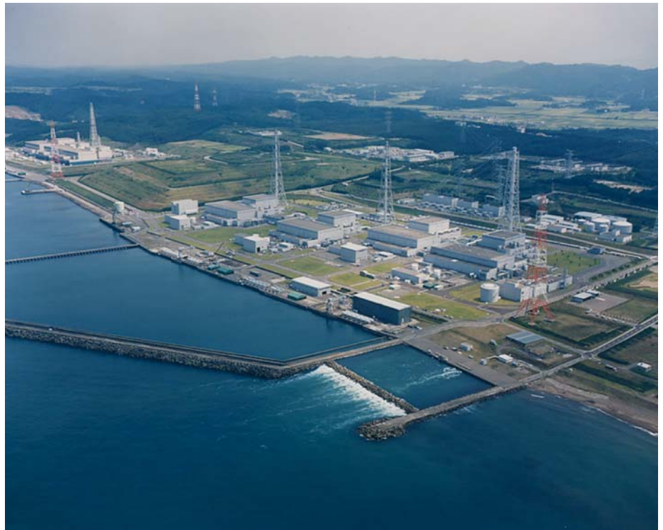
Vista aérea de la central de Kashiwazaki-Kariwa que resultó afectada por un terremoto.
